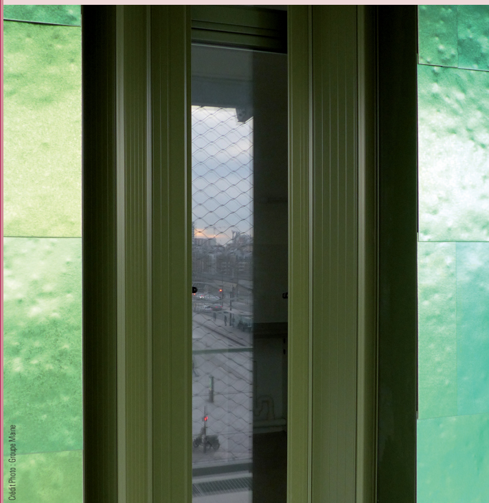
Groupe Maine : persienne coulissante recouverte d'une tôle aluminium laquée de 2 mm (cette tôle est repliée sur les champs du cadre, puis rivet), créée pour la Tour de la Biodiversité à Paris
