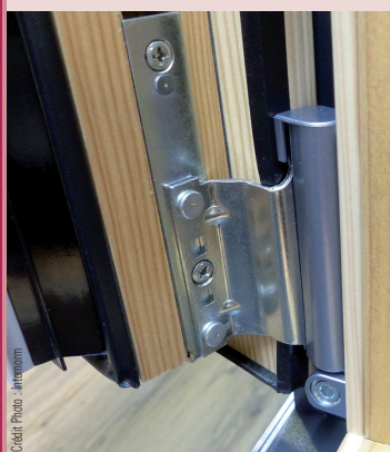
La crémone semi-fixe Internorm en standard, verrouille correctement la fenêtre 2 vantaux au niveau du 2 ème vantail semi-fixe, en renvoyant des points de verrouillage en partie haute et bas
