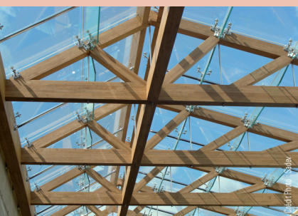
Verrière installée dans un Mall (centre commercial) en 2015 - fixations Sadev
