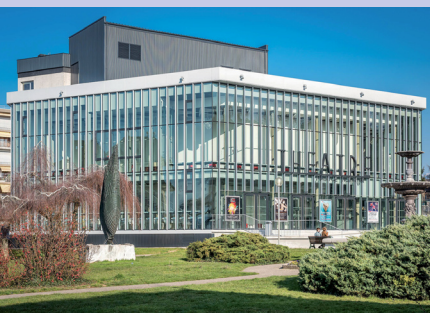
Epure et transparence pour le théâtre Maurice Novarina à Thonon-les-Bains (74), qui retrouve la finesse et le rythme serré de la façade d'origine avec les murs-rideaux Mecano (en trames verticale) ; et aussi les châssis Wicslide 24, les portes (bicoloration) et ouvrants pompiers Wicstyle 65
