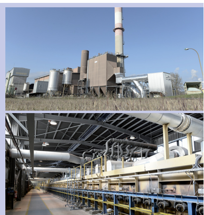
Le site d'Eurofloat, implanté sur 34 ha, accueille une technologie de pointe avec le nouveau four de 60 m de long et l'optimisation de la ligne float
