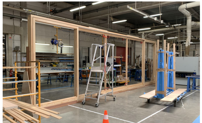
Usinage des menuiseries
