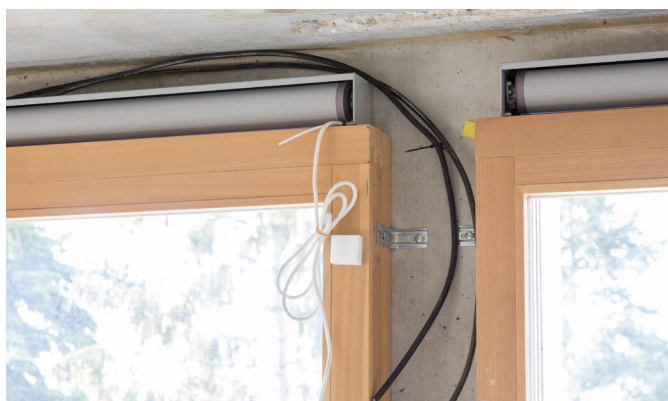
Coffre, ventilation, store, etc. tout sera caché dans le doublage.
