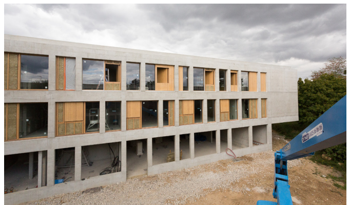
Parties pleines des ouvrants en mélèze et parties vitrées intégrées au béton.
