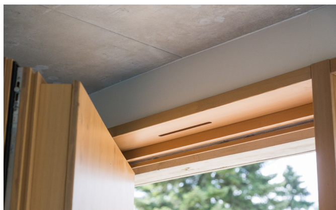
La partie ouvrante n'est pas la partie vitrée : les ouvrants sont pleins.
