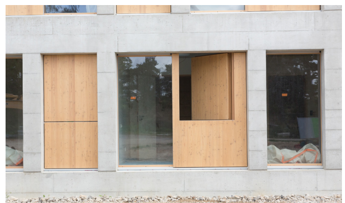
Parties pleines des ouvrants en mélèze et parties vitrées intégrées au béton.
