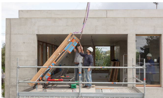
Pose des menuiseries à l'aide du chariot à vérins
