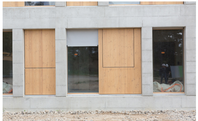
Store extérieur occultant et châssis bois.
