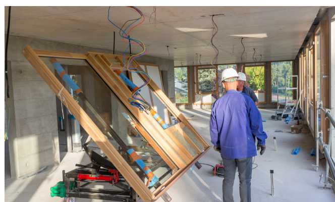
Pose des menuiseries à l'aide du chariot à vérins
